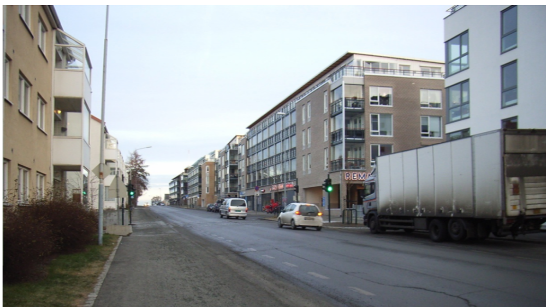
Figur 7 Signalanlegget i Stadsingeniør Dahls gate sett fra sør mot nord (Foto: Øydis Holsdal)
