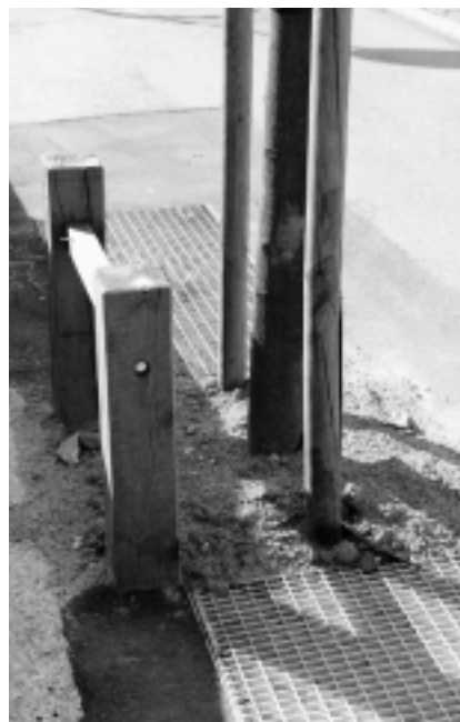
Elefantriste på hver sin side af træet, der står med opbindingspæle. Foran træet, og langs med vejen er placeret en træ-pullert, for at forhindre påkørsler og barkskader. Foto: Karsten Klintø.
