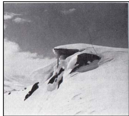
Figur 5.2.3: Skavlbrett forhindrer dannelse av skavl. Opprinnelig skavl ses i bakgrunnen. Kilde: Ramsli.
