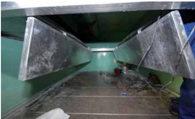
Figur 5. Hengslet luke for etasjebunn.
