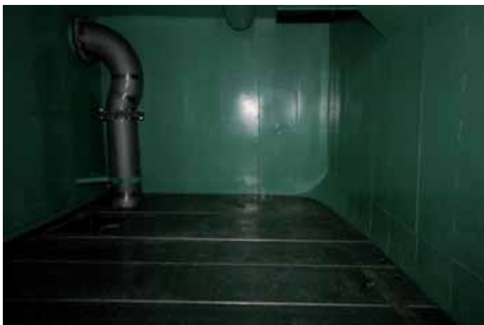
Figur 3a. Babord rom med ferdigmontert dobbelbunn, samt pumpekasse (se neste bilde).
