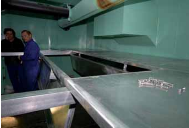
Figur 4. Etasjebunn under montering i styrbord rom.
