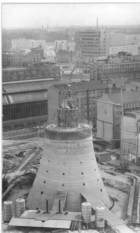
Figure 4. Bundesarchiv, Allgemeiner Deutscher Nachrichtendienst – Zentralbild [Image of the construction of the Berlin Transmission Tower – General German News Service (GDR)], 23 June 1966 (Bild 183-E0623-009-001). Photo: Joachim Spremberg
