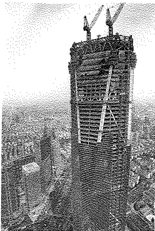
4/ Kohn Pedersen Fox, Shanghai World Financial Center , Shanghai, 2008. Foto di cantiere: in evidenza le superstrutture stabilizzanti (super-colonne, super-diagonali) di connessione tra i piani.
