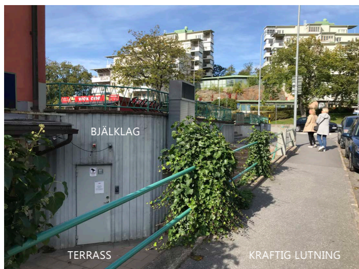
Figur 13. Byggnadstekniska utmaningar. Bildkälla: Rasmus Klingstedt (2019)
