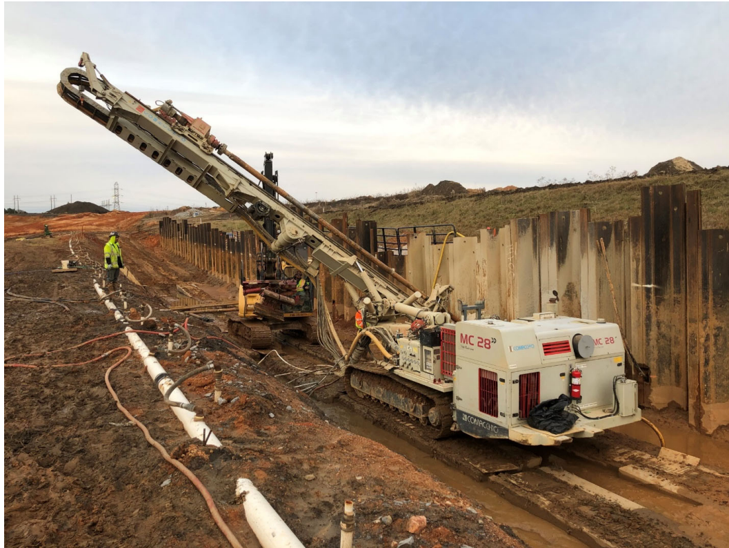
Figure 11-2. Comacchio MC 28 drill rig.
