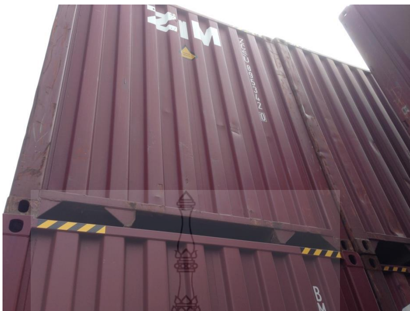
ภาพที่ 2.6 แสดงภาพลักษณะผนังของตู้คอนเทนเนอร์ที่นำมาออกแบบ
