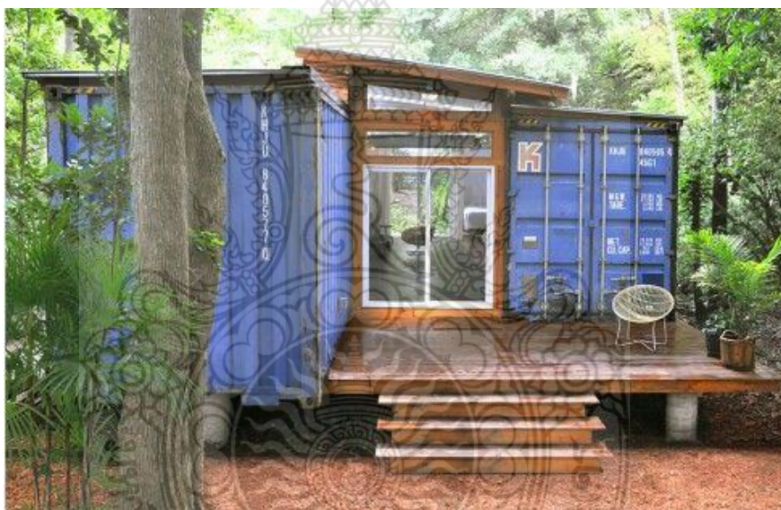
ภาพที่ 2.3 แสดงการนำตู้คอนเทนเนอร์มาทำที่พักอาศัย
