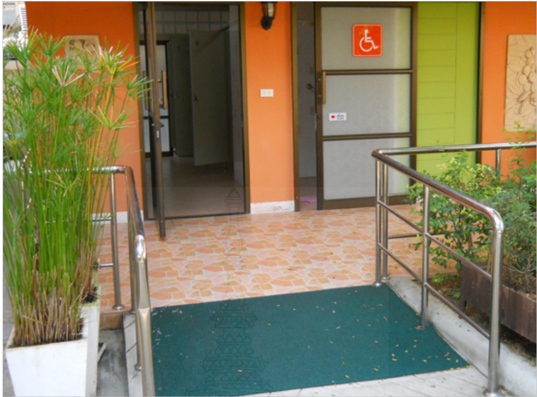
ภาพที่ 2.30 ทางลาดสำหรับผู้สูงอายุบริเวณห้องน้ำสาธารณะ
