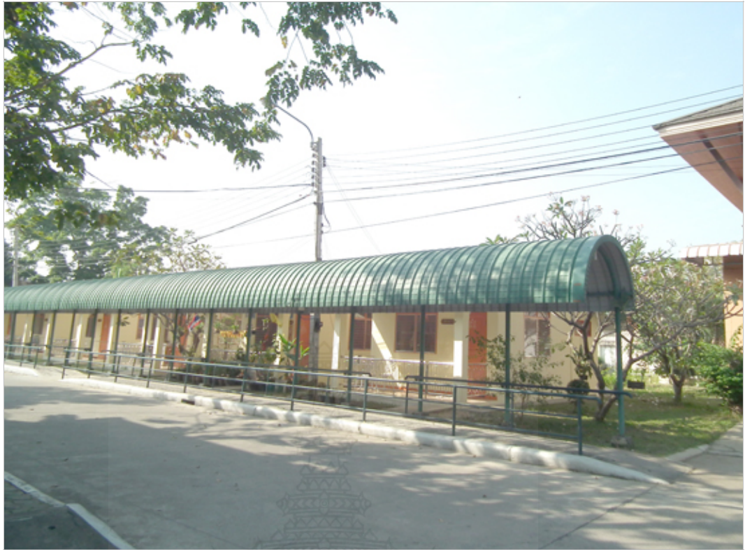
ภาพที่ 2.20 ทางเดินไปยังอาคารที่พักด้านหลังมีส่วนของทางลาดสำหรับรถเข็น
