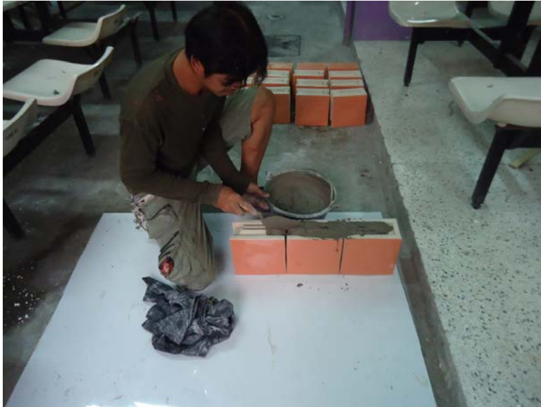
ภาพที่ 8 ก่อผนังชั้นที่ 1
