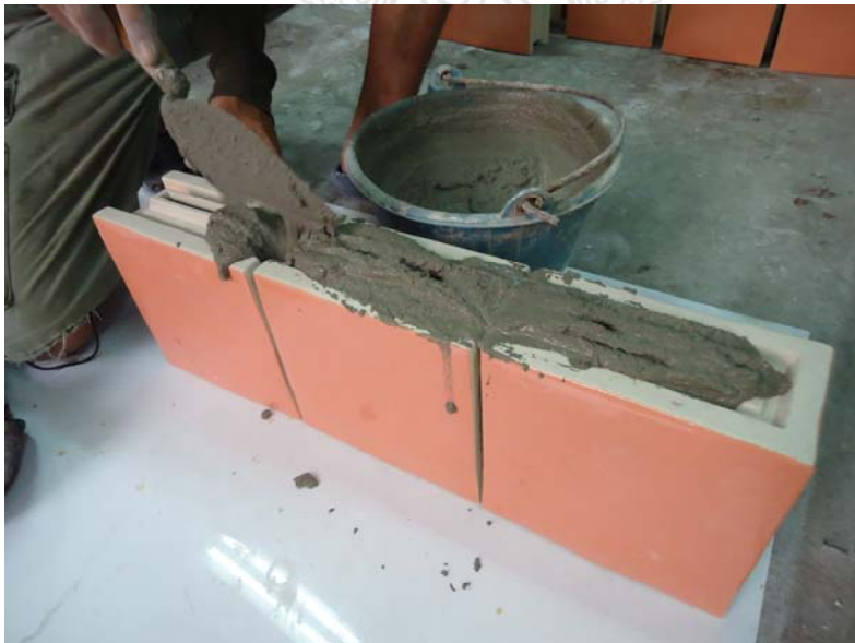
ภาพที่ 9 การก่อโดยใช้ปูนก่อสำเร็จรูป
