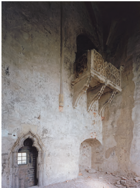
Abb. 16 Bautzen, Ortenburg, Matthiasturm, Empore vor der Sanierung.
