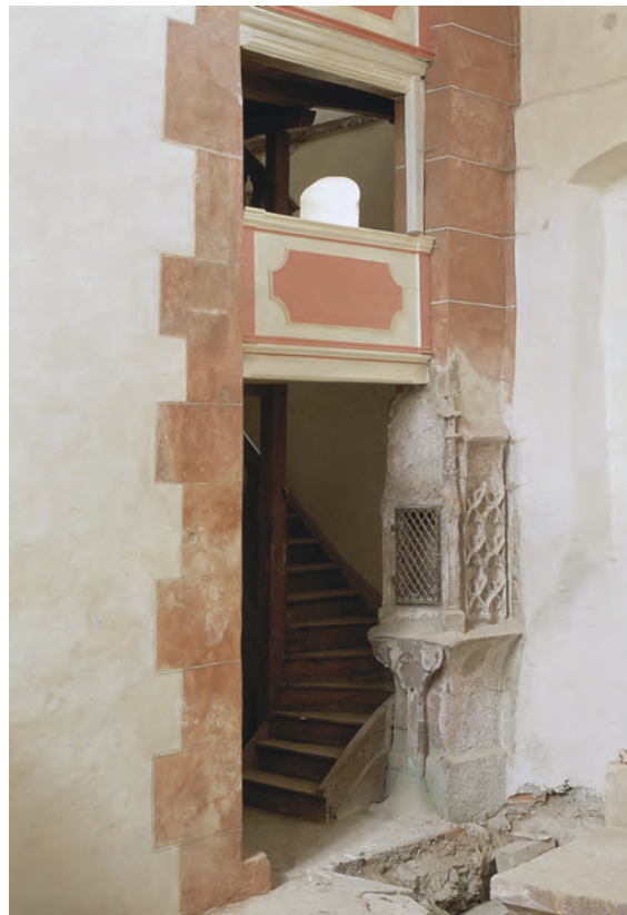
Abb. 12 Rochsburg, Schlosskapelle, barocke Emporenanlage und Sakramentshäuschen, Zustand während der Sanierung 1996.
