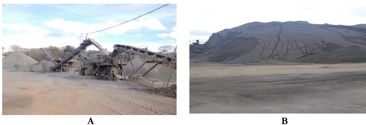
Figura 5: A) Vista do britador e pilhas de pó britado. B) Pilha de pó britado na pedreira
