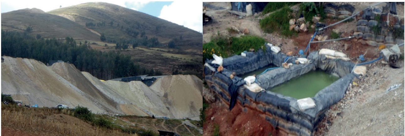
Fotos 1, 2. Relavera de Cerro El Toro y pozas de lixiviación de minerales sulfurados polimetálicos
