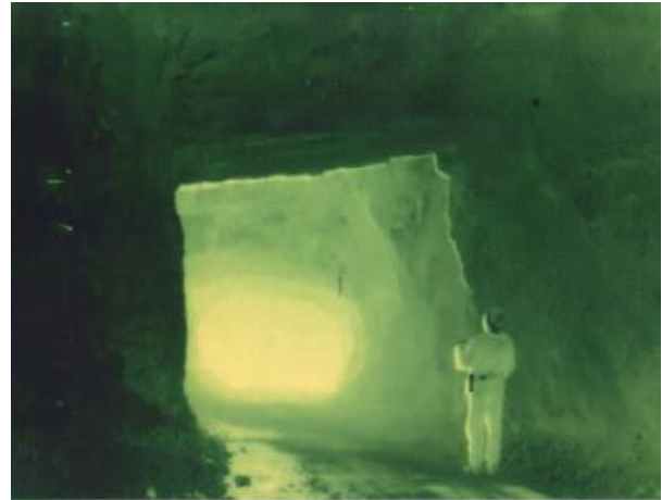
Figura N° 3. Roca con el eje ternario cristalinio tendiente a la horizontalidad muy estabilizada y no requiere sostenimiento a 120m de punto de la fotografía anterior de la misma 42-3159. más abiertos.
