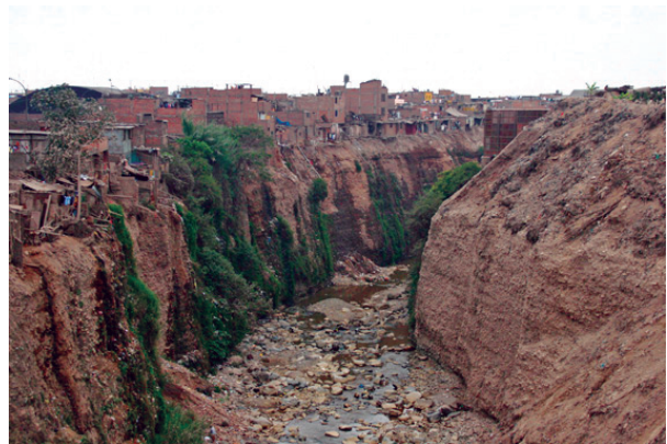
Figura N° 2. Viviendas ante eminente colapso debido a la erosión lateral del río Rímac en el tramo próximo al Puente del Ejército (Villacorta et al.) 2014).
