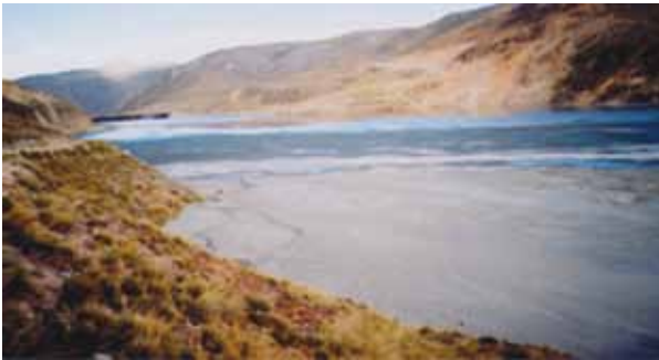
Figura N.º 3. Relavera Yauricocha. Área del dique de concreto.
