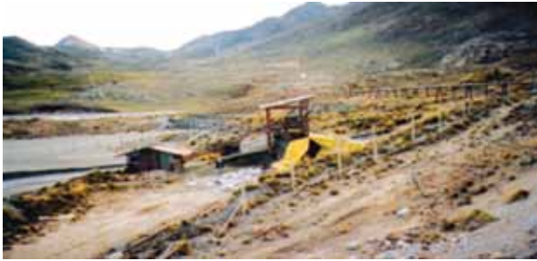
Figura N.º 2. Relavera Yauricocha. Punto de descarga de tubería de relave.
