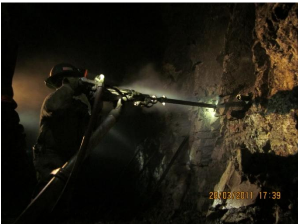
Foto N° 2-1: Instalación de un Split Set.
