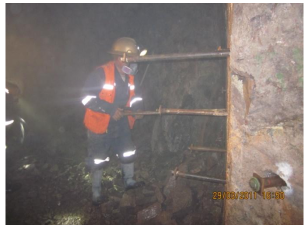
Foto N° 4-2: Instalación de los Hydrabolts
