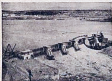
MEYSSE (Drôme): Le Barrage
