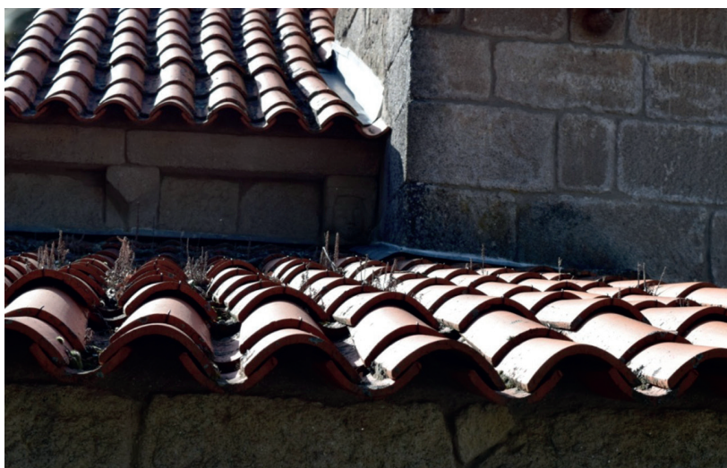
Fig. 4. Église de São Tiago Adeganha (Torre de Mancorvo, Portugal), inspection réalisée par HeritageCare el 22/10/2018: toiture (toit) de la sacristie.
