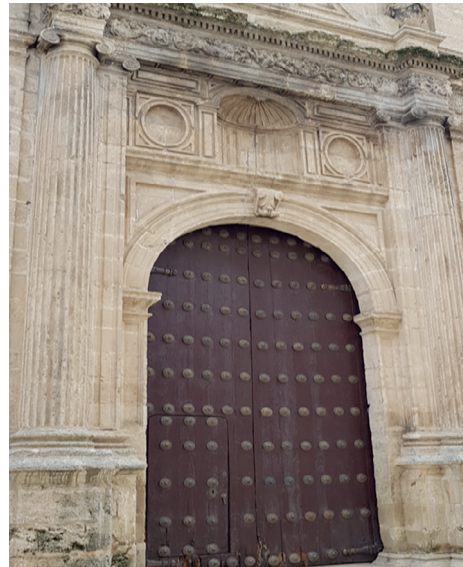
Fig. 8. Chapelle de l'Hôpital des Cinq Plaies, siège actuel du Parlement d'Andalousie (Séville, l'Espagne), inspection effectuée par HeritageCare le 23/10/2018: détail de la porte.
