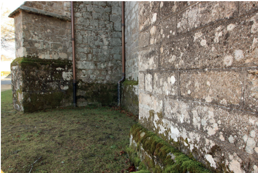
Fig. 5. Igreja de Sainte Croix (Rosiers-d'Égletons, sudoeste da França), inspeção efetuada por HeritageCare em 26-02-2019.
