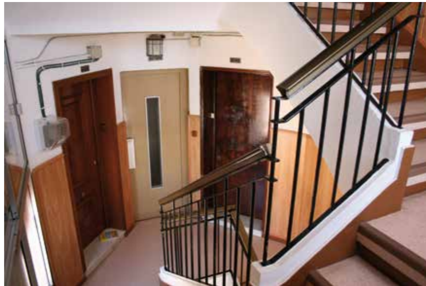
| Condiciones de habitabilidad. Actualización de elementos de paso e instalaciones. @ IAPH
