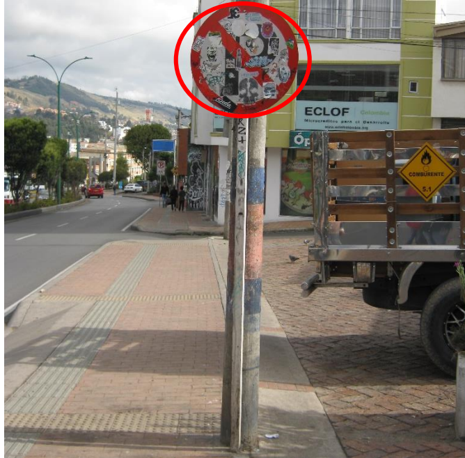
Figura 34. Señal reglamentaria en mal estado.
