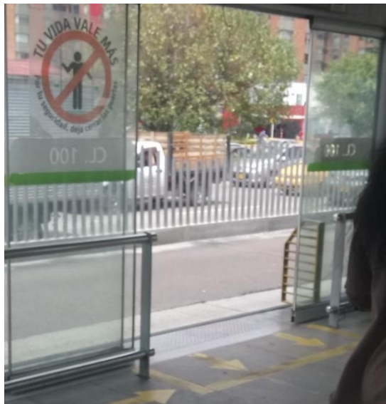
Figura 20. Demarcación horizontal en el vagón puerta 1
