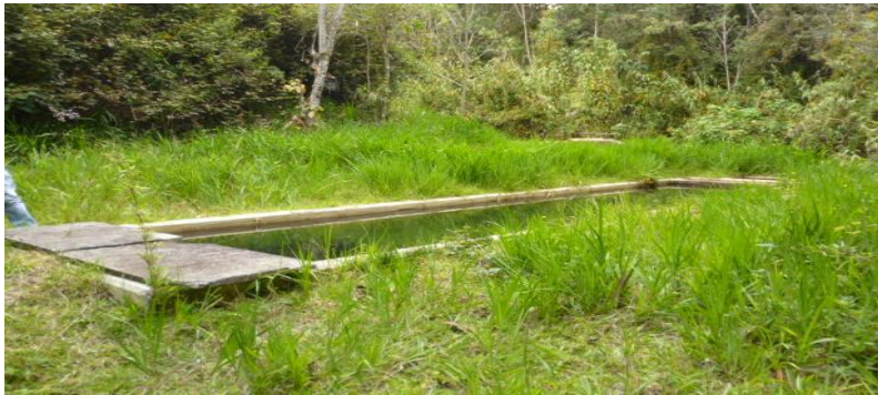
Figura 3. Tanque desarenador la Honda
