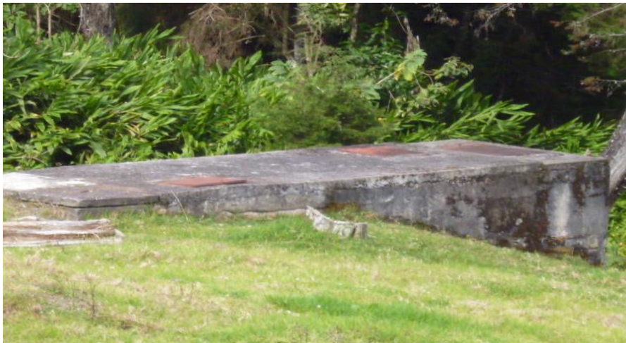
Figura 6. Tanque desarenador Limón y Peñol
