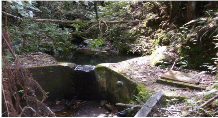
Figura 4. Bocatoma el Limón
