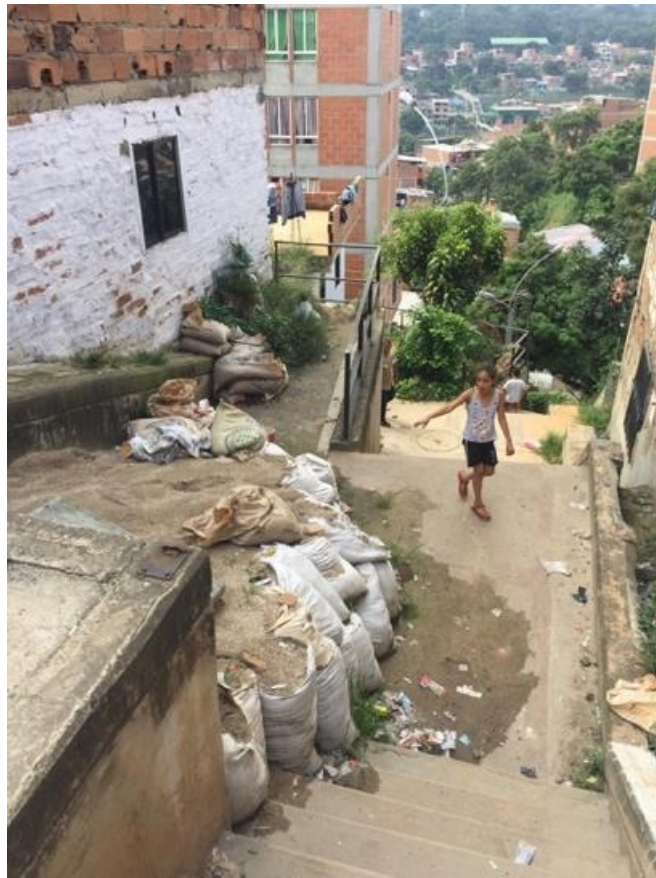
Imagen N°36. escombros en los bajos del bloque 3. (Fuente: Imagen tomada por la autora)
