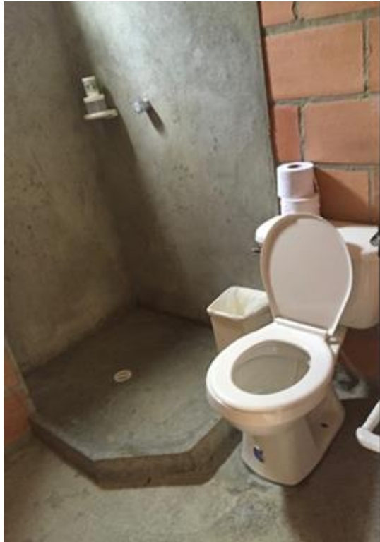
Imagen N°23. Baño original, bloque 12. (Fuente: Foto tomada por la autora).
