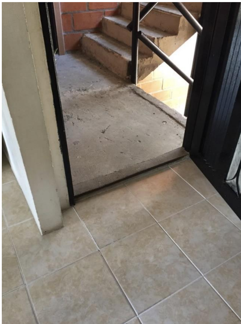
Imagen N°25. Entrada apartamento bloque 4. (Fuente: Foto tomada por la autora).
