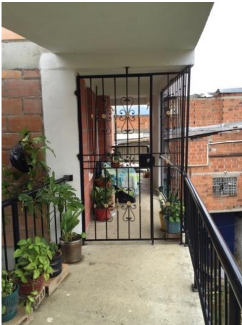
Imagen N°17. Cerramiento de corredor en el bloque 12. (Fuente: imagen de la autora).
