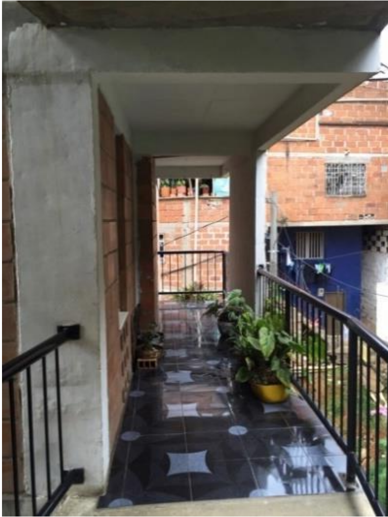
Imagen N°16. Corredor recubierto en baldosa. Bloque 13. (Fuente: imagen de la autora)
