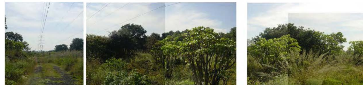
Foto 10 Torre alta tensión vista en algún punto de la senda principal. (Ver plano esc:1:5000 Foto 4)
