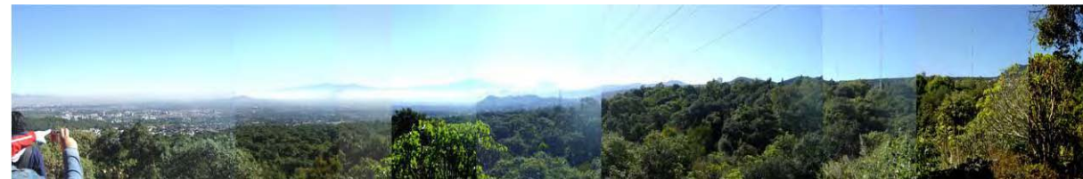
Foto 8 Torre alta tensión vista desde mirador dos. (Ver plano sendas esc:1:5000 Foto 2)
