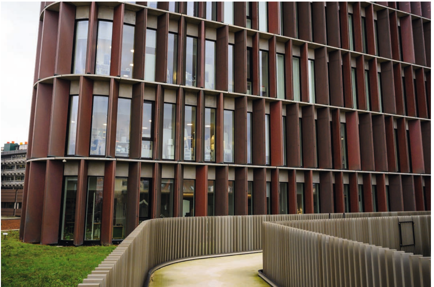
Her starter den 350 meter lange sti i trætophøjde. Den forbinder Blegdamsvej forpladsen med Nørre Ålle forpladsen. Skodderne er fuldautomatiske og bevæger sig efter solens gang. De er perforerede for at bevare udsynet. Foto: Michael Barrett Boesen.
