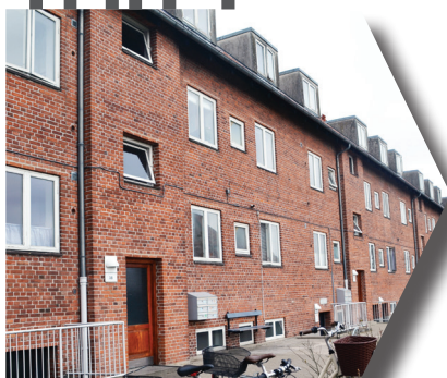
Bygning som helhed
