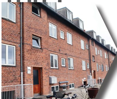
Bygning som helhed
