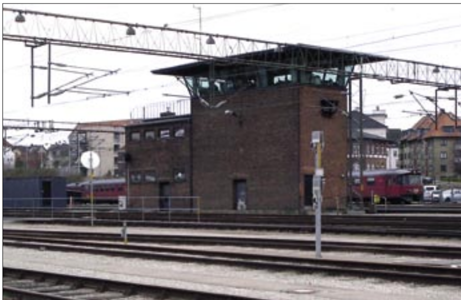
Den nuværende kommandopost i Helsingør blev opført i 1955/56, og stationens nye relæsikringsanlæg blev taget i brug i 1956. Foto den 7. april 2007 af Henning Knudsen
