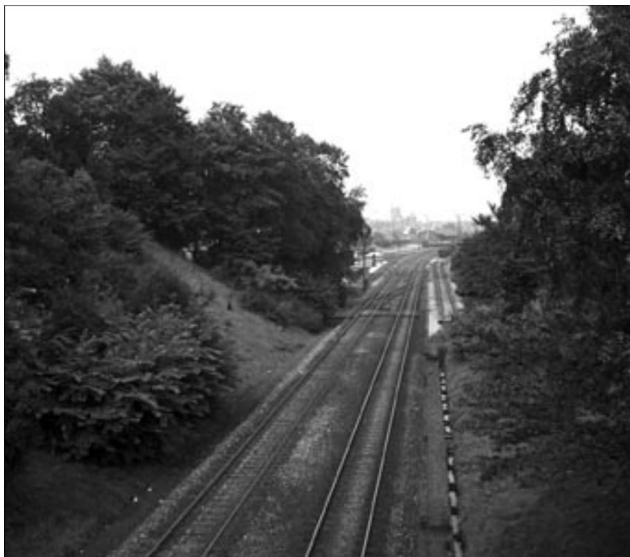
Nordbanen og Kystbanen føres ind til Helsingør gennem en stor udgravning af Flynderborgbakken. Jord herfra blev brugt til opfyldning i Trykkedamsbugten. Sammenlign i ørigt gerne med billedet side 23 øverst. Foto 1952. Arkiv: Jernbanemuseet
