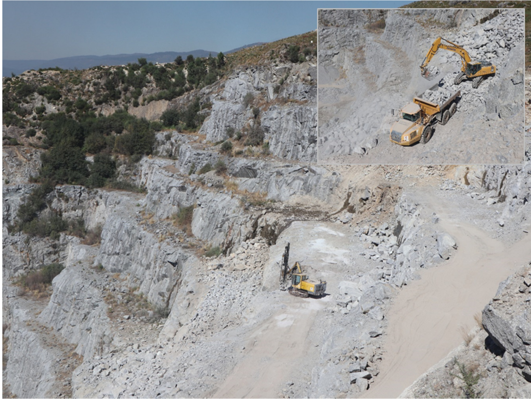
Operação de perfuração e carregamento do material da Pedreira de Serdedelo (Ponte de Lima, Viana de Castelo, Portugal).
