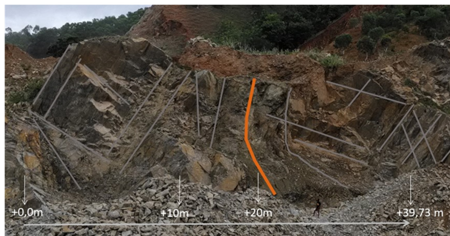
Figura 96. Caracterização de pormenor da bancada a desmontar segundo o grau de alteração (W), grau de fracturação (F) e classe de resistência (S). A cor laranja refere-se a uma falha.
