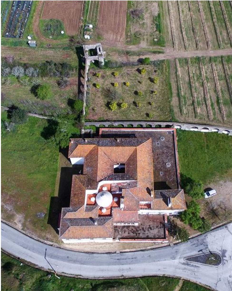
Figura 15 - Convento do Bom Jesus de Valverde. Vista aérea
