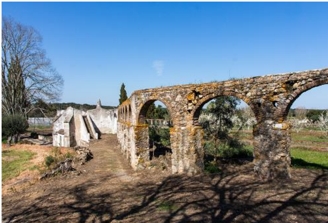
Figura 9 - Ligação do aqueduto à Casa da Água
