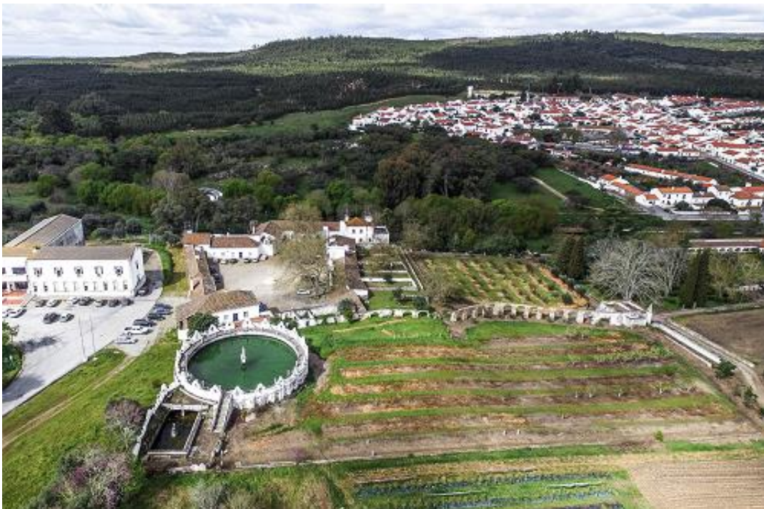
Figura 7 - Ligação do tanque principal à Casa de Água. Vista aérea
