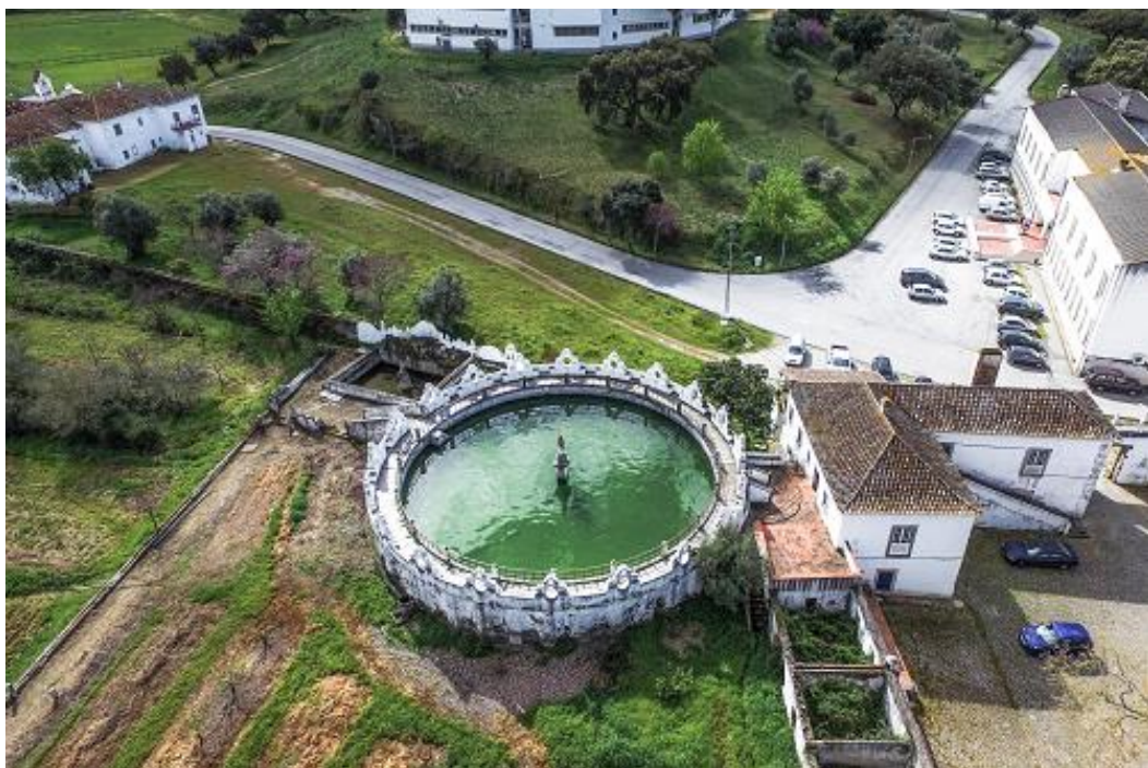
Figura 6 -Tanque principal. Vista aérea
