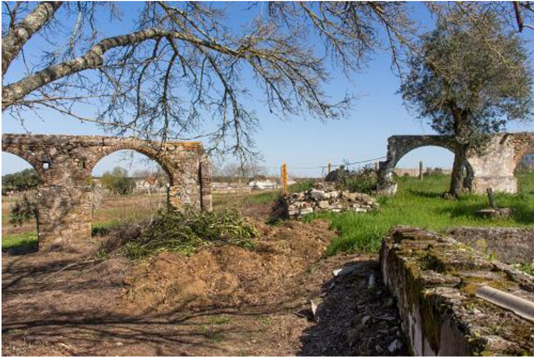
Figura 10 - Estado de conservação de alguns troços do aqueduto
