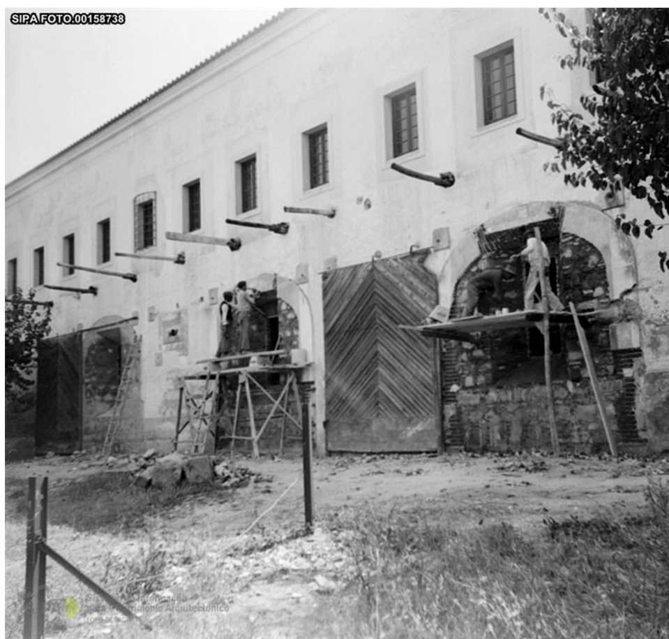
Figura 2 - Alçado nascente: abertura dos vãos para permitir a entrada das alfaías agrícolas (1949)
