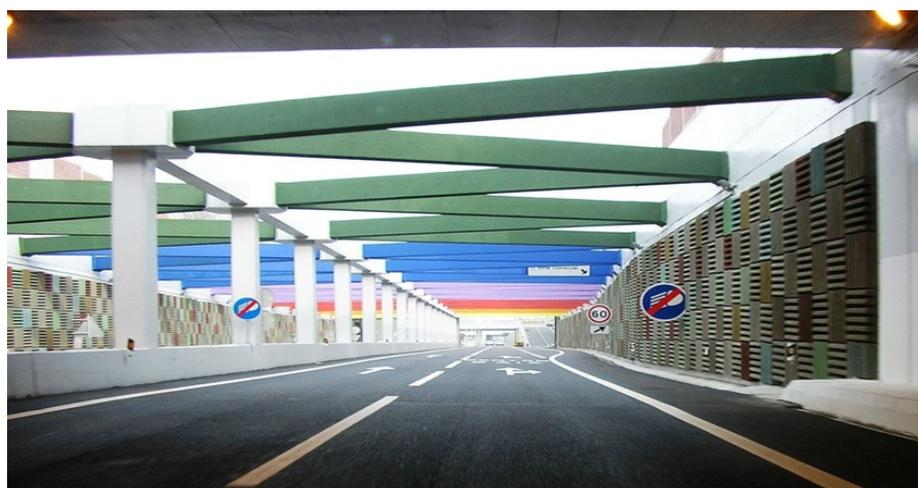
Figura 5.7: Exemplo de proteção acústica ao longo da VCI [44]
