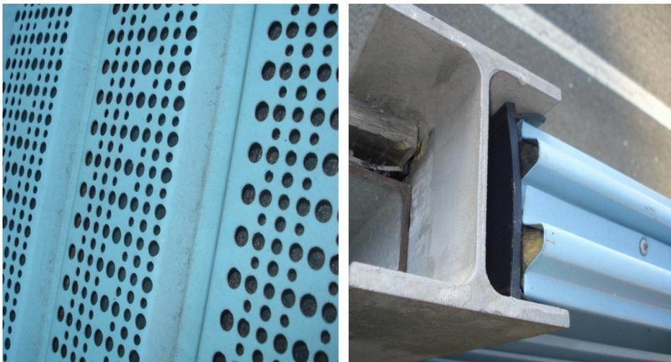
Figura 6.8: Lado perfurado da barreira virado para a VCI (esquerda) e composição interior da barreira em lã mineral (direita) [Foto do Autor]
