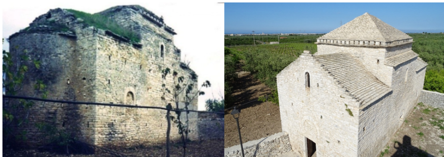
Figura 3- Chiesa di Ognissanti prima e dopo il restauro
