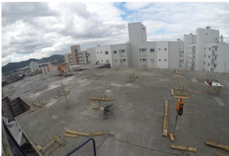
Figura 11 - Locação dos Pilares
