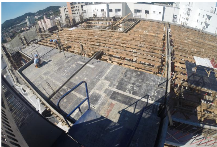
Figura 20 - Colocação do Assoalho da Laje
