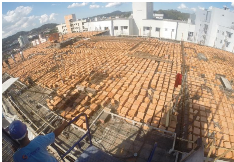
Figura 27 - Montagem das Armaduras Negativas
