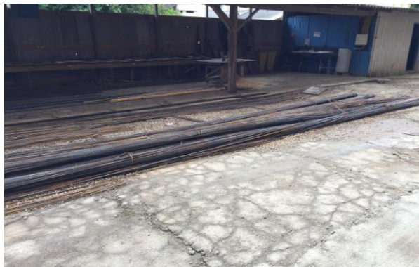
Figura 46 - Barras de Aço Estocadas
