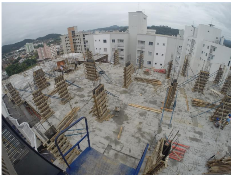
Figura 15 - Montagem das Formas dos Pilares
