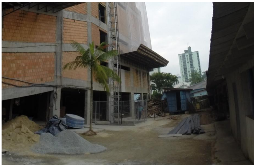
Figura 9 - Vista Canteiro de Obras
