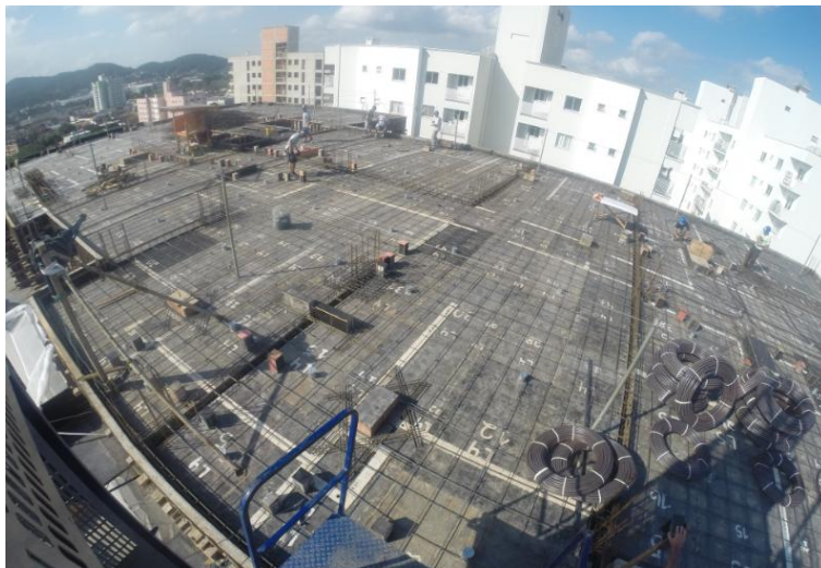
Figura 26 - Montagem das Armaduras Positivas da Laje
