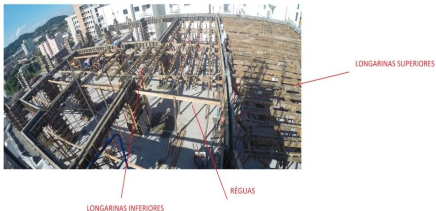
Figura 18 - Colocação das Longarinas.
