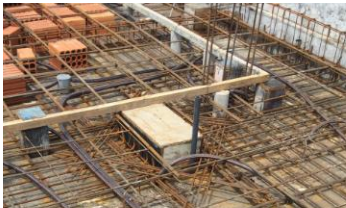
Figura 31 - Montagem das Formas dos Rebaixos
