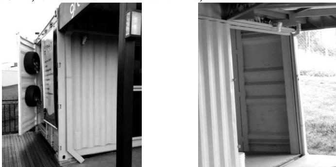
A fixação das coberturas metálicas foi feita após a execução das aberturas e da instalação das esquadrias de portas e janelas. As Figuras 88-a e b ilustram a cobertura Sudoeste apoiada no contêiner térreo número 2, sendo que a cobertura Noroeste foi soldada no contêiner térreo número 1, conforme mostrado na Figura 88-c
