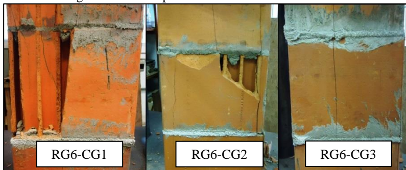
Figura 4.31 – Ruptura característica dos prismas grauteados moldados com os blocos B6 e argamassa C – Etapa Referência.
