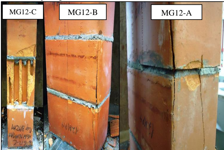
Figura 4.36 – Ruptura característica dos prismas grauteados moldados com os blocos B12 – Etapa Arg. Mista.
