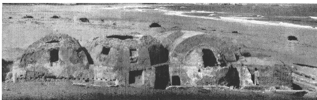
Fig. 12. Foto di repertorio delle Terme della Caccia di Leptis Magna durante le operazioni di scavo (da WARD-PERKINS - TOYNBEE 1949, tav. XXXVa).
