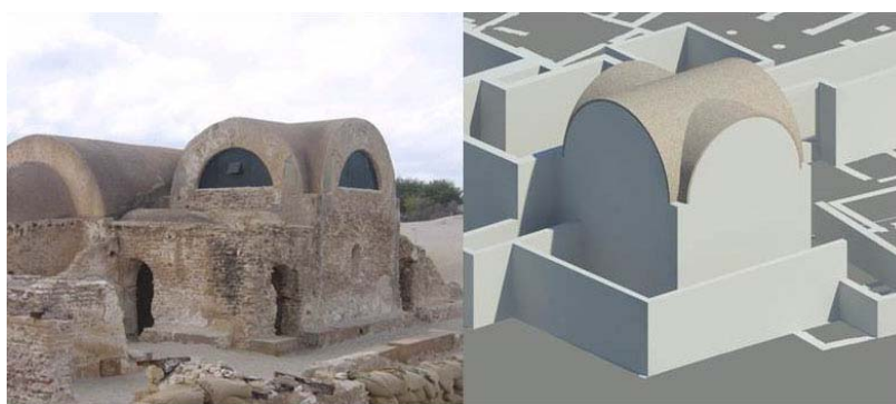
Fig. 17. Resa volumetrica della copertura a crociera dell' apodyterium delle Terme Centrali su modello di quella della vasca quadrangolare delle Terme della Caccia (elaborazione grafica dell'autore).
