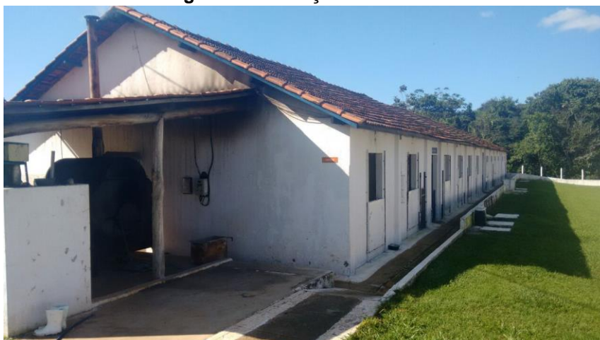
Figura 3- Instalação da Creche.
