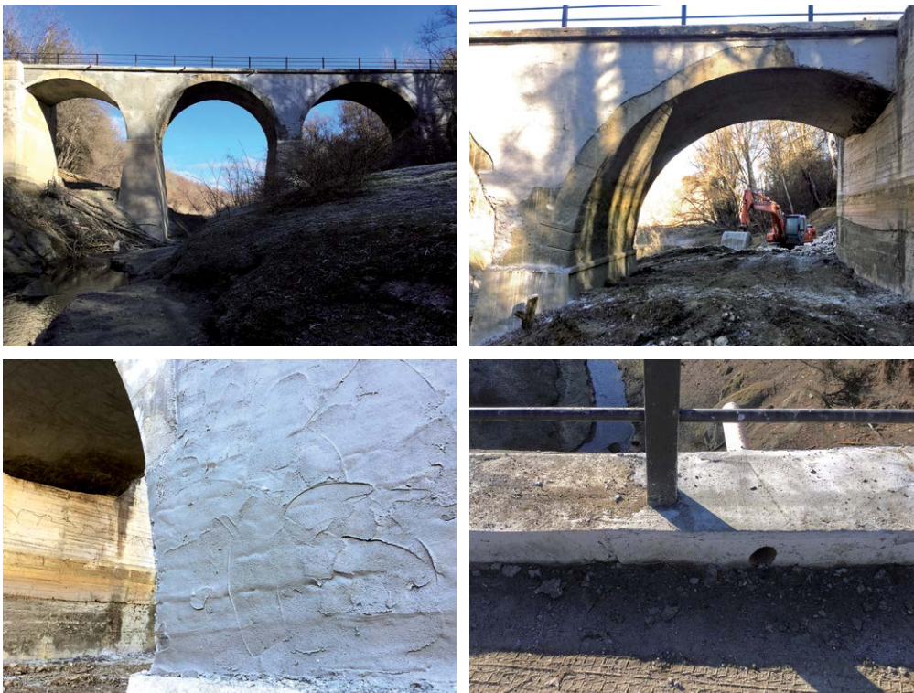
Figura 9 Ponte a Cinque Occhi dopo i lavori di consolidamento statico: superfici murarie riparate con cementi fibrorinforzati e sistemazione dei cordoli perimetrali della carreggiata e tubazioni di deflusso acque sede viaria.
