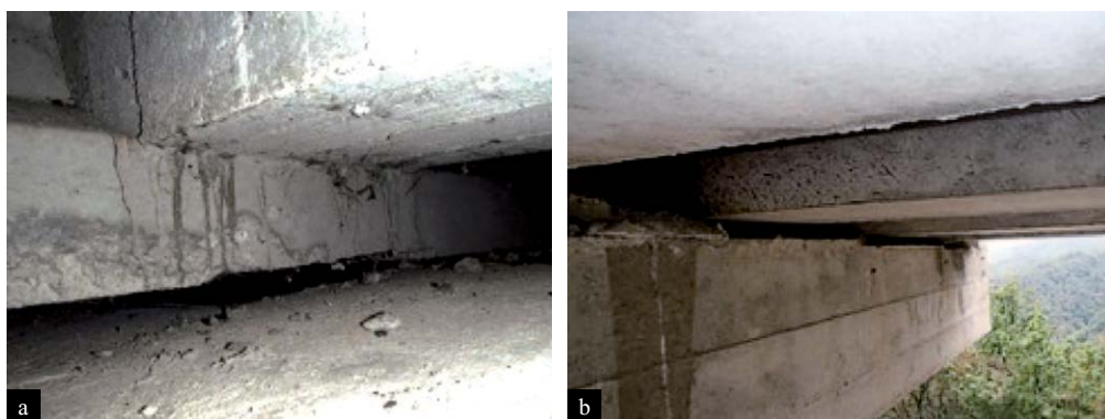
Figura 15 Appoggi elastomerici di uno dei viadotti in c.a. esaminati lungo la SS685; non si notano segni di eventuali scorrimenti relativi (per concessione di Totaro).
