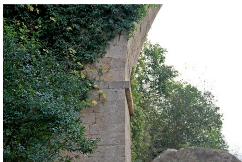
Figura 12 Imposta dell'arco e pila in muratura.
