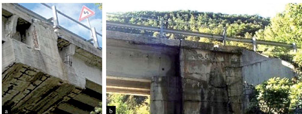
Figura 16 Danni da martellamento e danni pregressi ai viadotti in c.a.: (a) danni al traverso e al diaframma trasversale lungo la SS685, coordinate 42.756556 N, 13.277111 E; (b) danni ad una spalla lungo la SS4, coordinate 42.699565 N, 13.251978 E (per concessione di Totaro).
