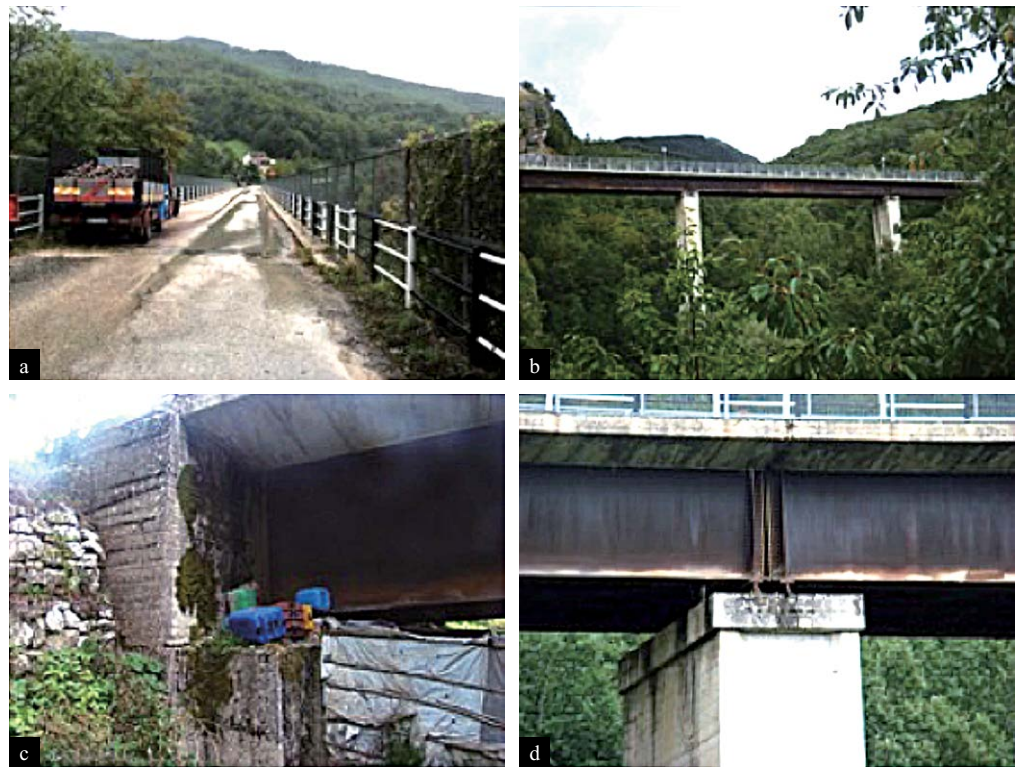
Figura 19 Ponte Ramazzotti - Struttura composta acciaio- calcestruzzo (42.7276 deg, 13.311 deg): vista generale del ponte (a, b), spalla (c) appoggi (d).
