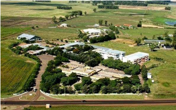
Figura 9 – Campus Uruguai, situado na BR 472, rodovia que liga o Brasil ao Uruguai. Fonte: Figura extraída da internet.
