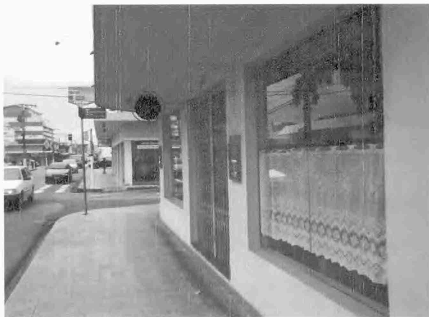
Figura 6: Fachada do imóvel Fonte: dados primários.
