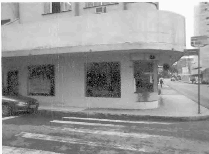
Figura 5: Vista lateral do imóvel Fonte: dados primários.
