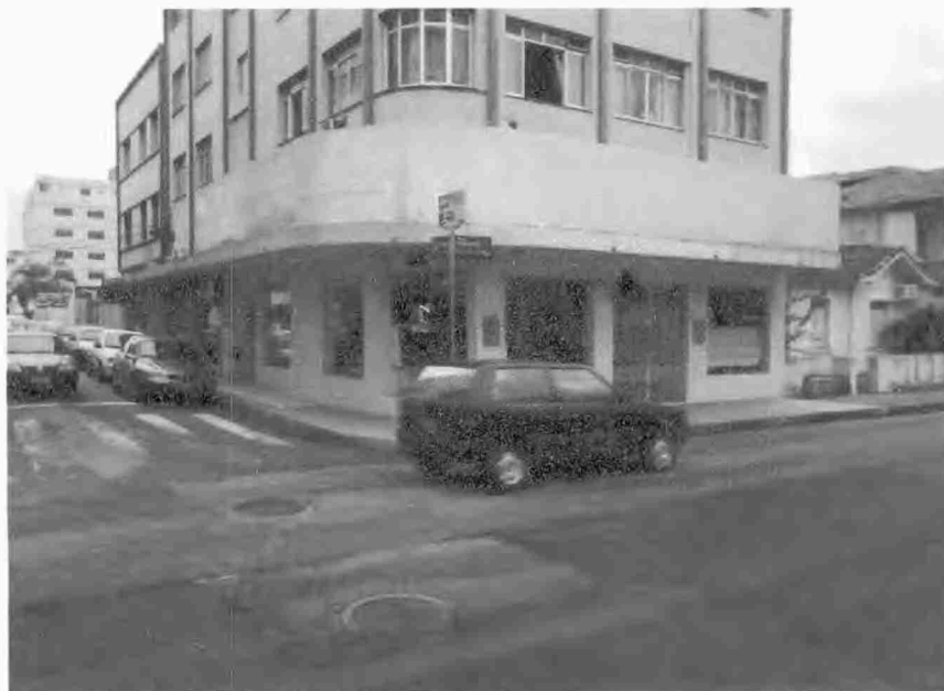
Figura 7: Vista frontal do imóvel Fonte: dados primários.
