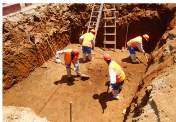
Terrassement : réglage fond de fouille
