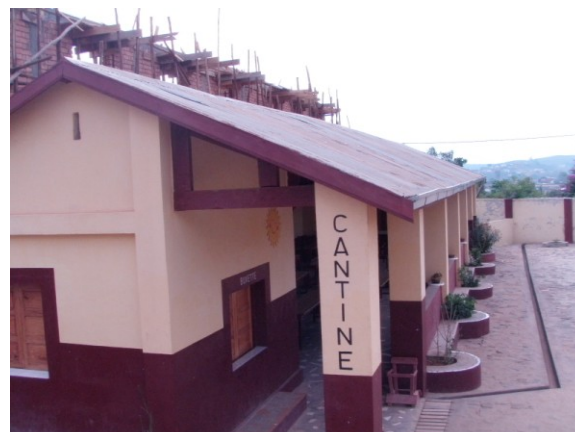
Toiture d'approvisionnement du REEPS
