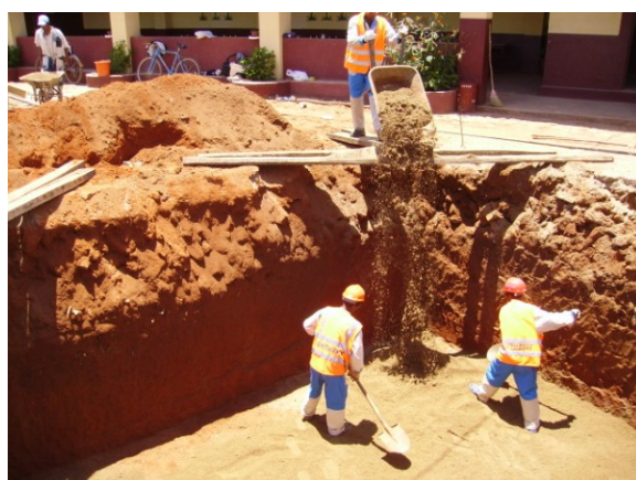
Réalisation lit de sable
