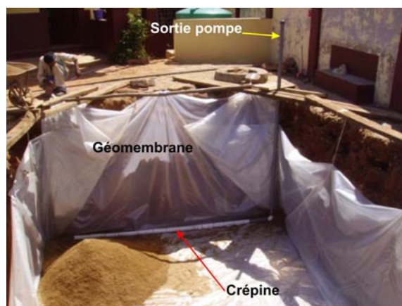
Pose géomembrane et crépine
