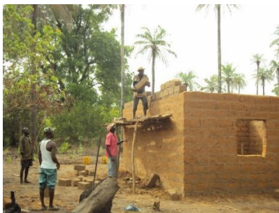
Comunidade construindo a Escola comunitária de Bidjope. Foto de Lasalete Coelho
