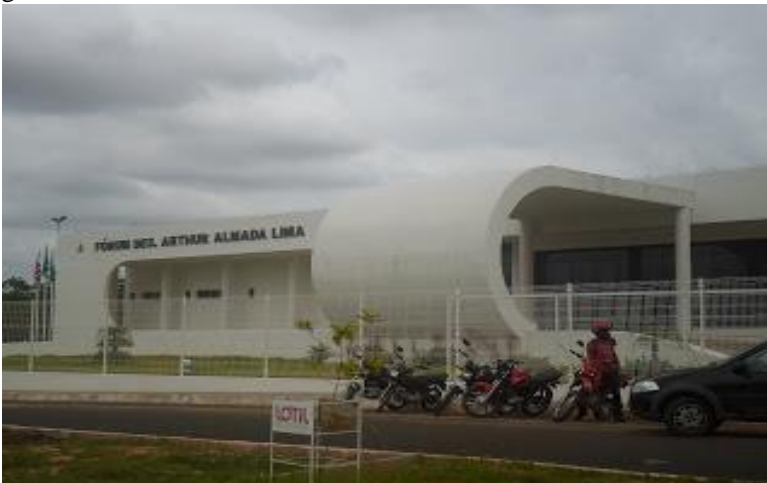
Figura 17 - Fachada externa do Fórum Des. Arthur Almada Lima
