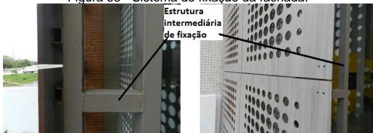
Figura 58 - Sistema de fixação da fachada.
