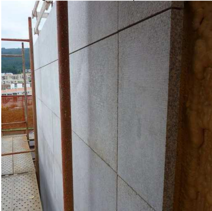
Figura 8 - Revestimento em pedra natural.
