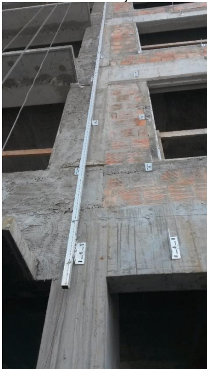
Figura 40 - Sistema de fixação na base suporte.
