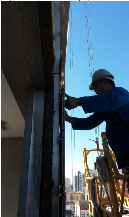
Figura 45 - Encaixe da peça cerâmica.
