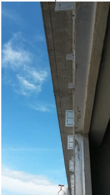
Figura 42 - Fechamento superior da fachada ventilada.
