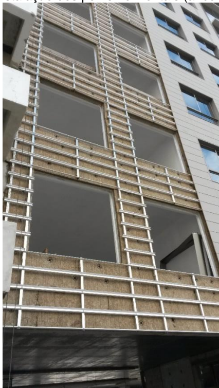
Figura 43 - Instalação dos perfis horizontais (ancoragem linear).
