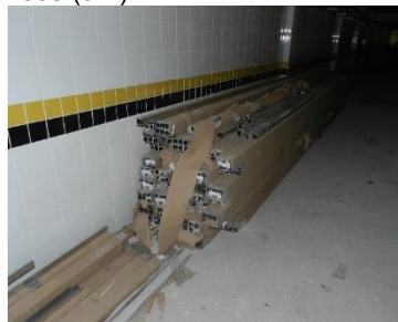
Figura 50 - Armazenagem dos materiais. Revestimento externo (esq.) e perfis metálicos (dir.).
