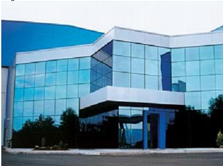
Figura 11 - Edifício com sistema de fachada ventilada em vidro.
