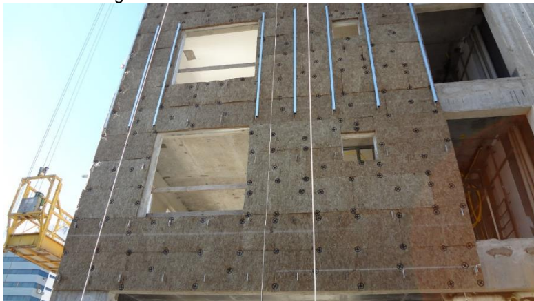
Figura 17 - Lã de rocha fixado à fachada.
