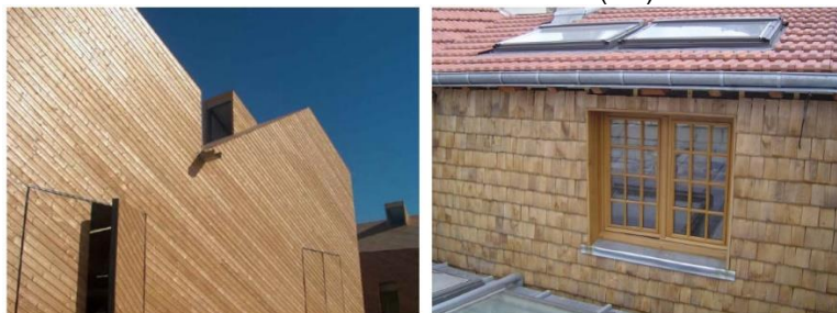
Figura 16 - Fachada ventilada de madeira maciça em ripas (esq.) e elementos de reduzida dimensão (dir.).
