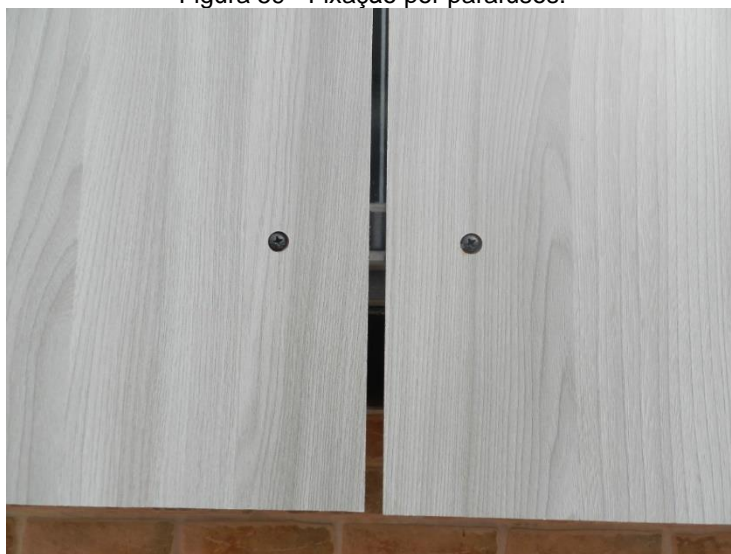
Figura 59 - Fixação por parafusos.
