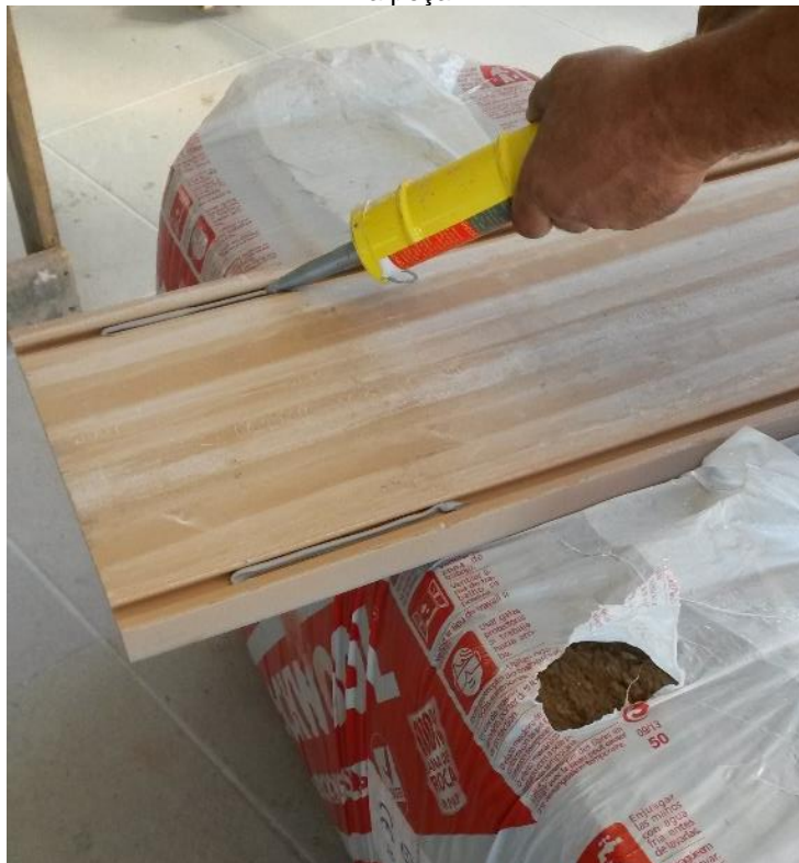
Figura 44 - Colocação de uma camada de poliuretano no tardoz na peça.
