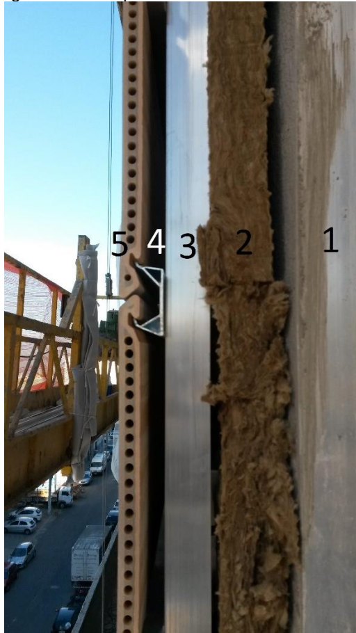
Figura 46 - Componentes da fachada ventilada.
