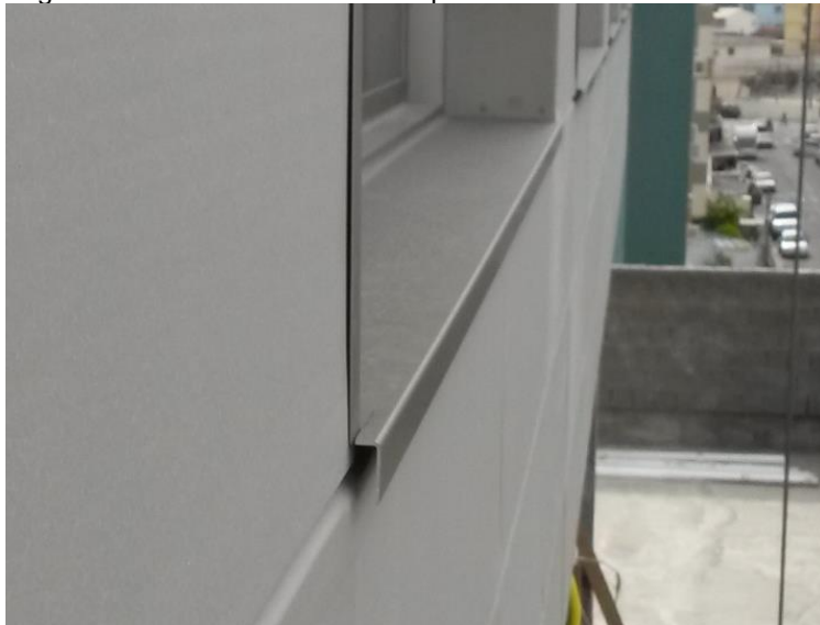
Figura 32 - Acabamento entre esquadria e revestimento externo.
