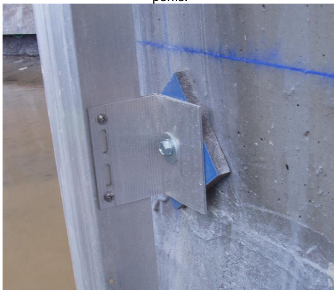
Figura 28 - Utilização de "calços" na afinação do prumo dos perfis.
