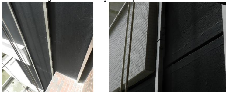
Figura 53 - Instalação dos perfis metálicos.
