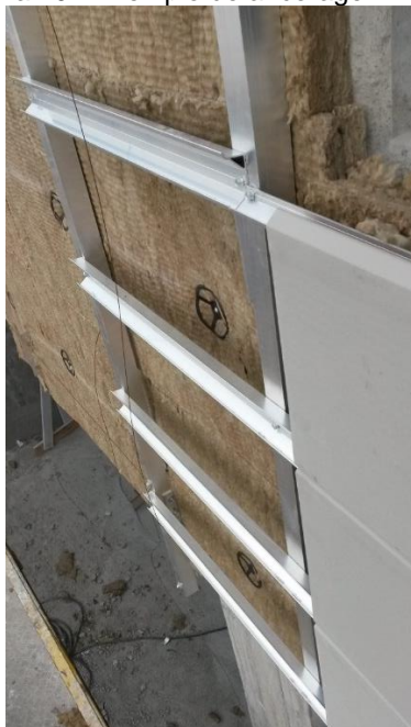
Figura 20 - Exemplo de ancoragem linear.
