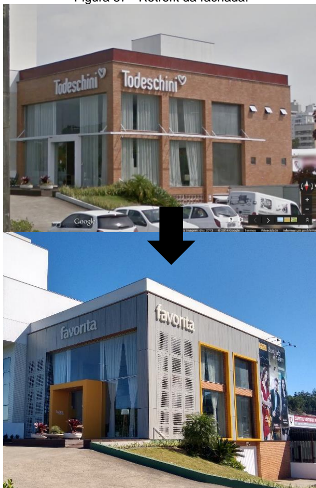
Figura 57 - Retrofit da fachada.
