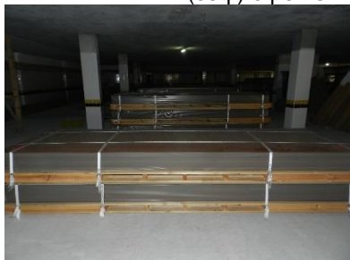
Figura 50 - Armazenagem dos materiais. Revestimento externo (esq.) e perfis metálicos (dir.).
