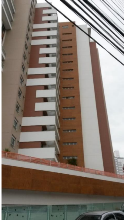
Figura 55 - Fachada ventilada instalada.
