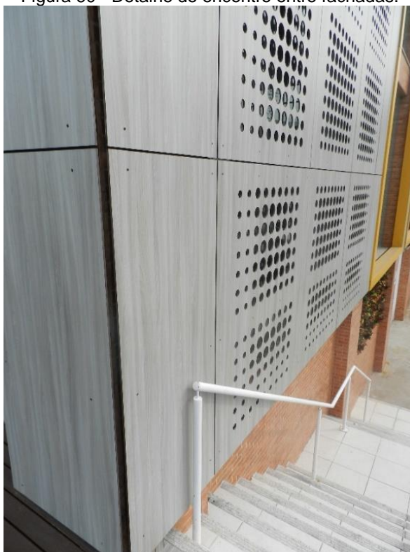
Figura 60 - Detalhe de encontro entre fachadas.
