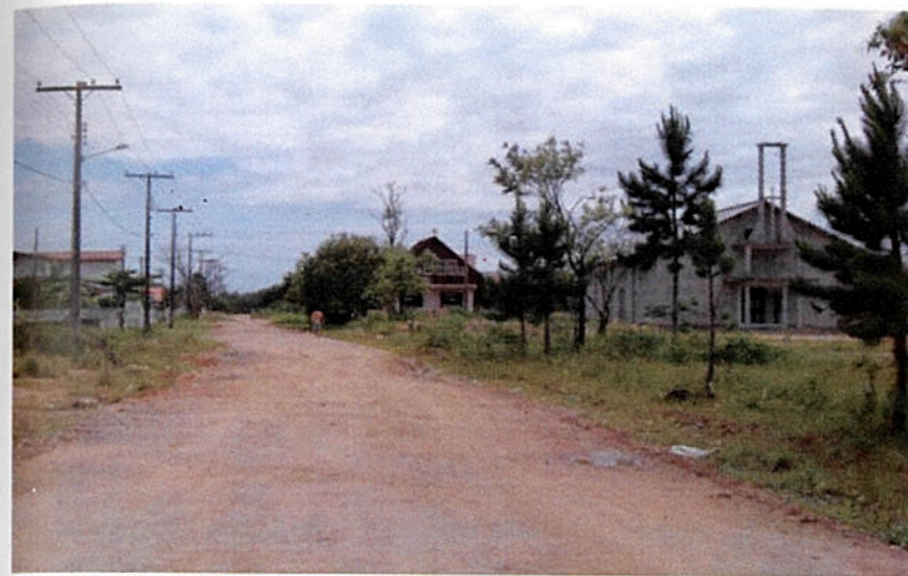
Foto 10 - Precariedade da Rua 17. Foto de Andréa C. 2009.
