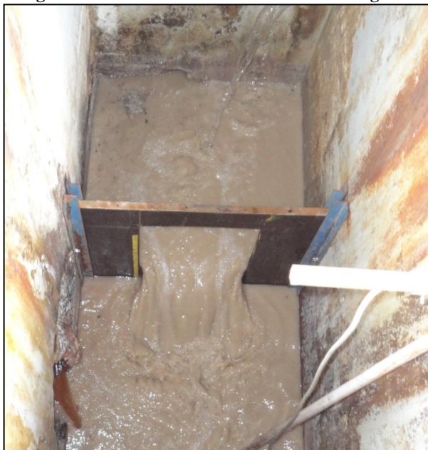
Figura 6: Vertedor em funcionamento. Visão geral.
