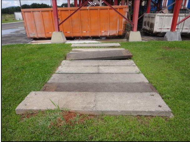
Figura 13: Caixa de passagem ao lado da área dos silos.
