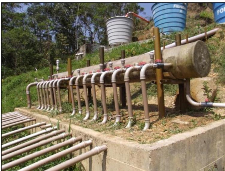
**Imagem 03:** Manifold de distribuição de água – Águas do Kiriri
