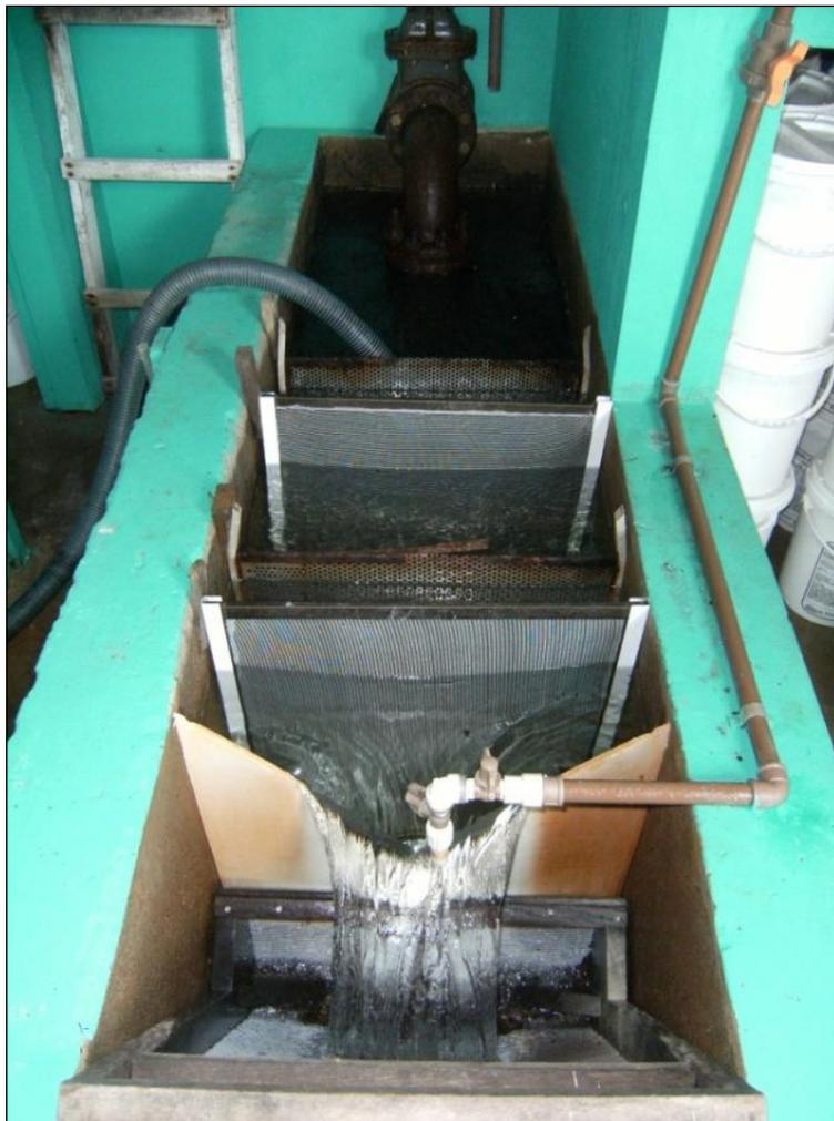
**Imagem 05:** Filtração e cloração da água bruta – CASAN Garuva
