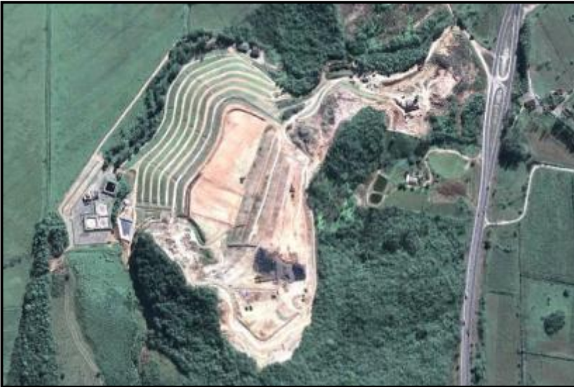
Figura 4 - Vista aérea do aterro sanitário de Biguaçu/SC.
